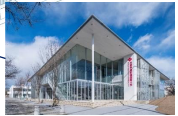
道路側から見える5号館の様子
